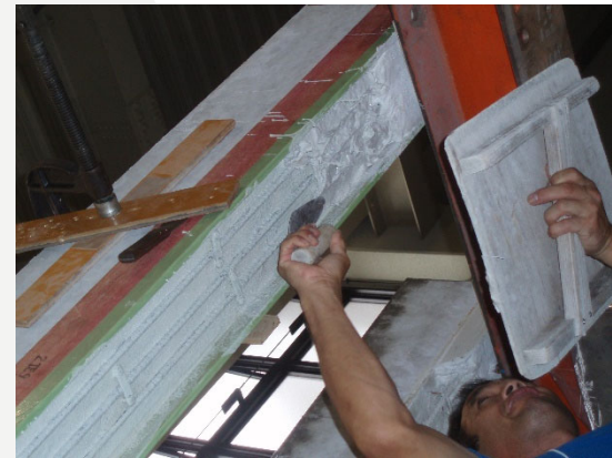
高靱性PCMによる断面修復（上向き施工）
