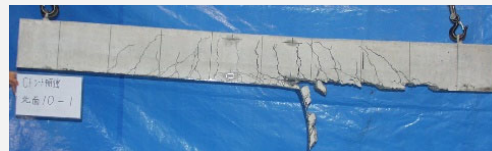
No.4 (CFRPシート貼付)
