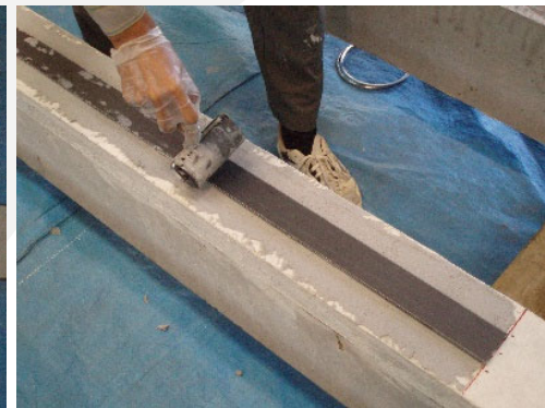
連続繊維プレート貼付
