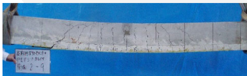
No.7 (高靱性PCM断面修復 + PEFRPシート貼付)
