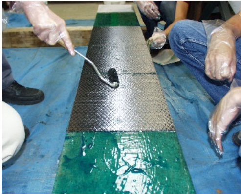
CFRPシート側面貼付
