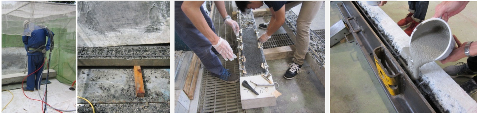
CFRPロッド・メッシュ埋設グラウト断面修復
