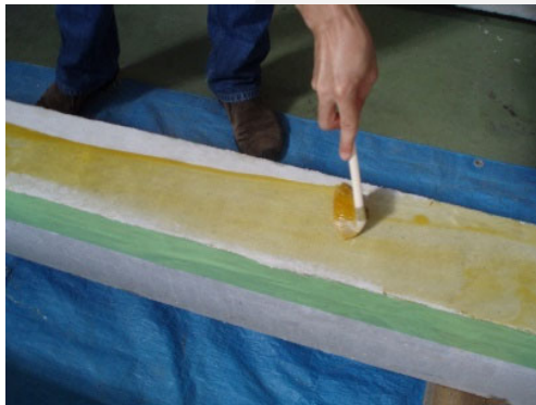
プライマー塗布
