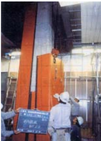
鋼板柱補強
