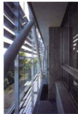
(d) ルーバー+ガラス設置
