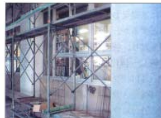
建物を使用しながらの施工
