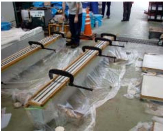
増厚工法 (配筋・型枠設置)
