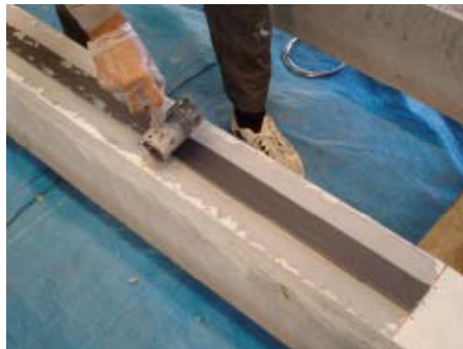
シート・プレート接着工法
