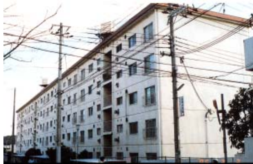
無被害の壁式RC造アパート
