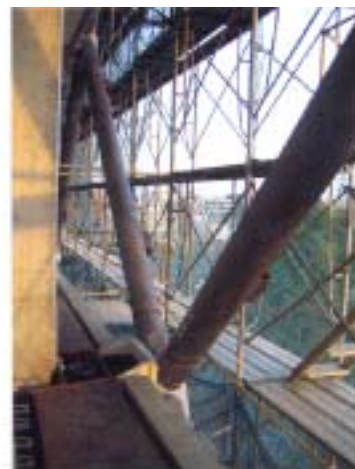
(c) ブレース取付け
