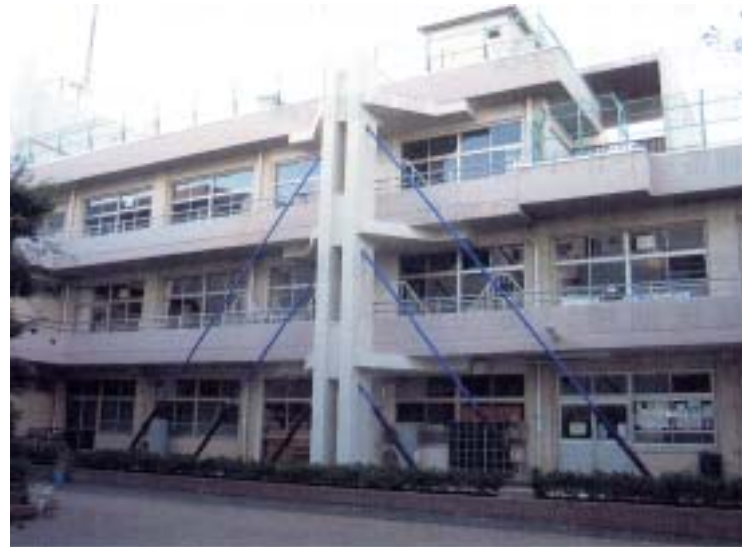
斜めPC鋼材を用いた外付け耐震補強工法
