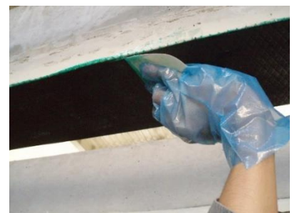
CFRP シート接着補強 (上向き施工)
