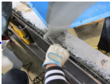
UHPFRC 断面修復
