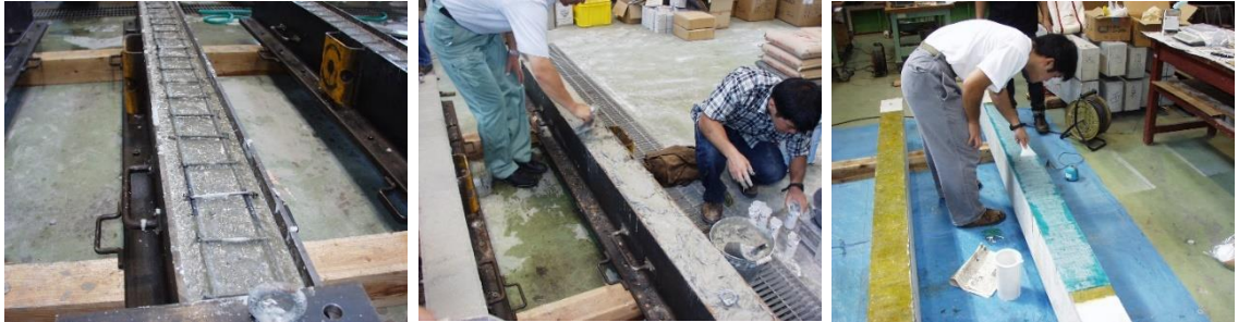
PEFRM 断面修復併用 PEFRP シート接着補強工法
