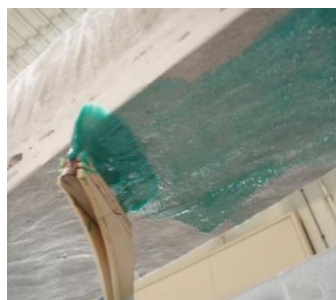
CFRP シート接着補強 (上向き施工)
