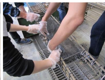
CFRP メッシュ配筋（上・下端筋フック定着）
