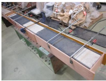
CFRP ロッド・メッシュ配筋
