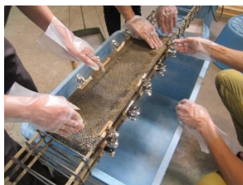
CFRP ロッド・メッシュ配筋
