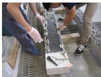
CFRP ロッド・メッシュ配筋
