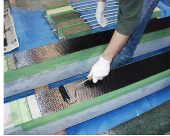
CFRP シート貼付
