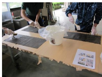
CFRP メッシュプライマー塗布
