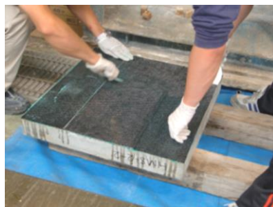
RC 版のシート接着補強
