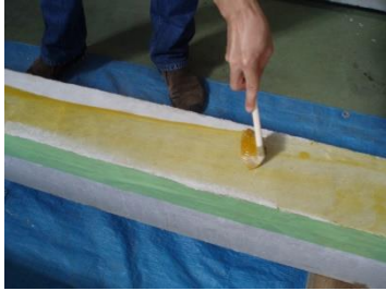
プライマー塗布
