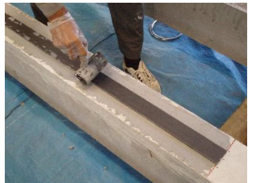
CFRP プレート貼付
