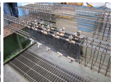
CFRP メッシュ配筋（上・下端筋フック定着）
