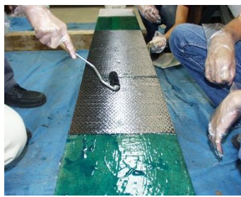
CFRP シート側面貼付
