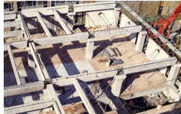
図 1.2.2 プレキャスト (PCa) RC 工法
