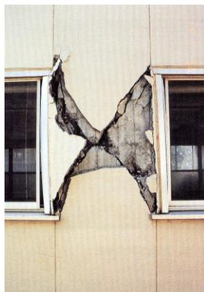
図 5.6.10 短柱のせん断破壊
